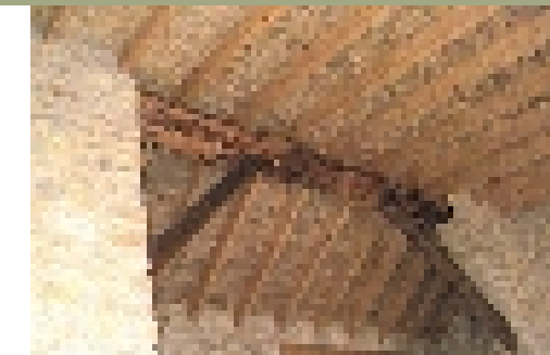
Cubierta rehabilitada con cañizo
