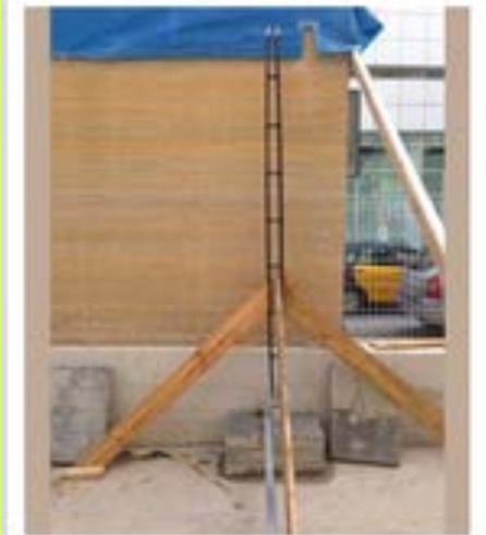
Montaje Estructura Tous
