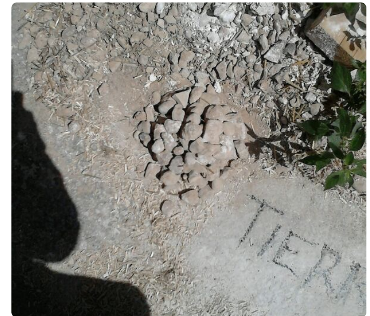
Comprobación punto puesta a tierra
