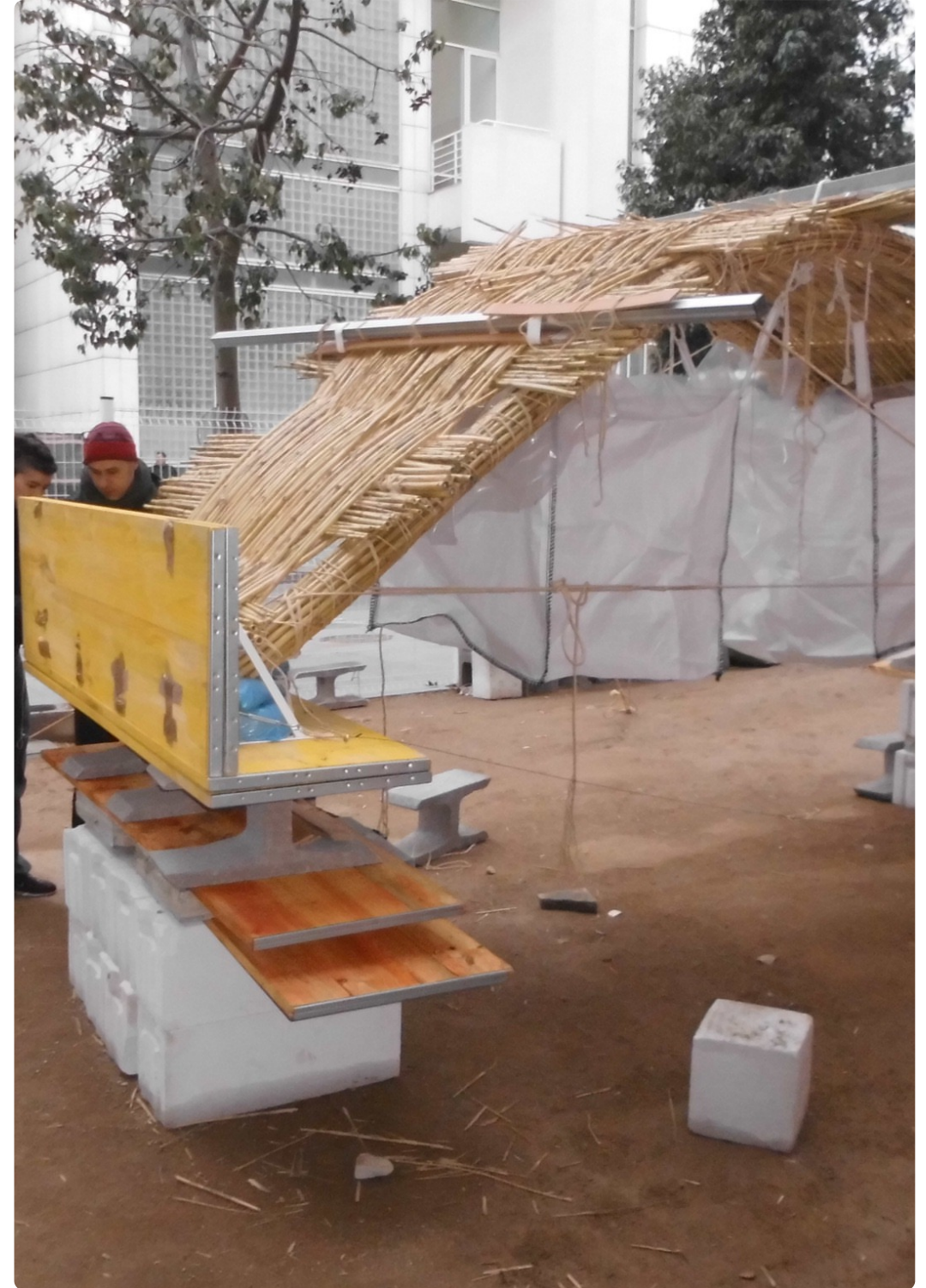
Fotos Evento 4.14 Ejecucion prueba de carga 2º Dia
