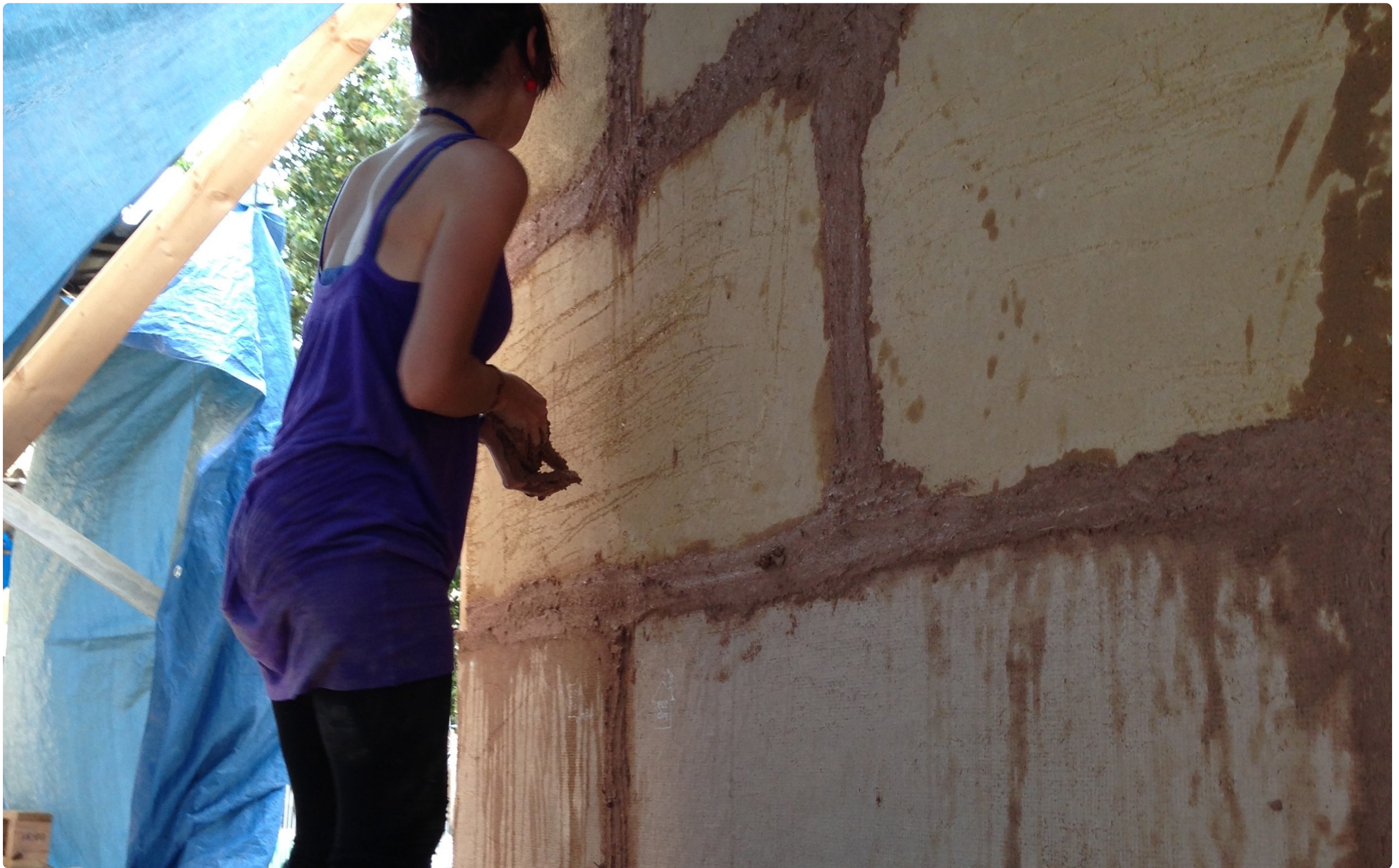
Fotos Evento 6.16 14|06|2014 Evento: Colocación de Paneles de Arcilla y continuación montaje de estructura
